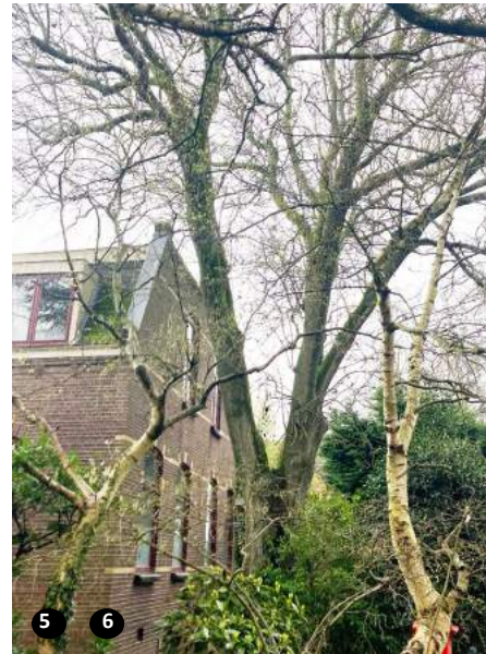
5 6 2 berken op voorgrond staan in de verdrukking van de grote es tussen gevel en straat
